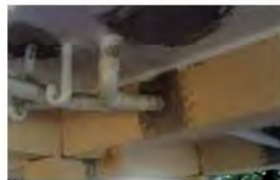
Perforación de elementos estructurales para paso de instalaciones
