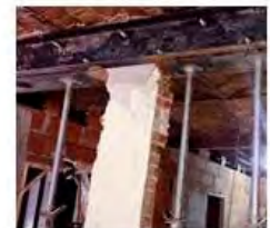
Retiro de perfiles de acero
