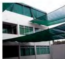
Colocación de malla sombra sobre elementos estructurales
