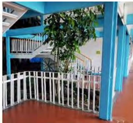
Marcos rígidos metálicos con muros divisorios de mampostería
