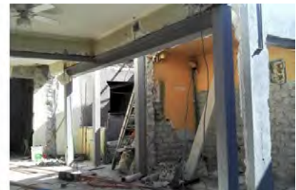
Reforzamiento de traves
