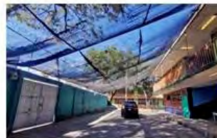
Colocación de malla sombra sobre elementos estructurales
