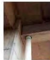
Perforación de traveses o columnas
