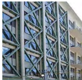
Colocación de contraenteos
