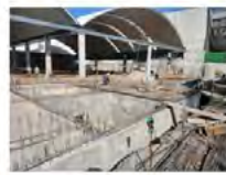
Cajón de cimentación
