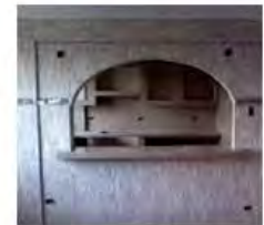
Apertura de vanos (huecos) en los muros
