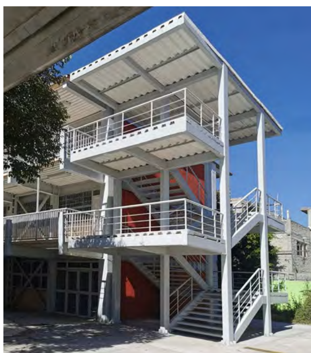
Escalera de emergencia
