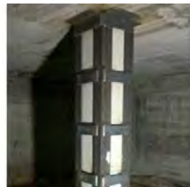
Reforzamiento de columnas
