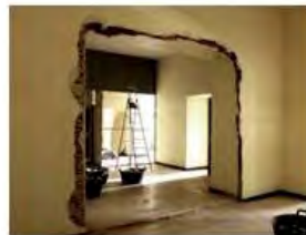
Demolición de muros
