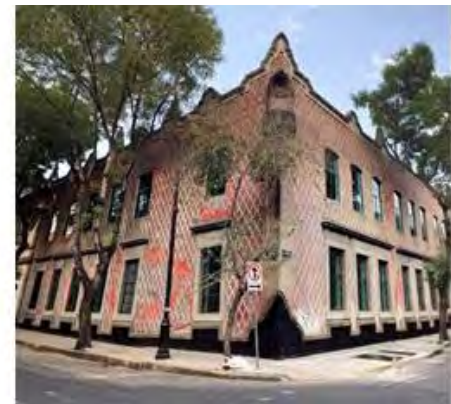
Muros de carga de mampostería
