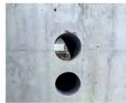
Perforación de muros
