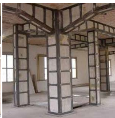
Reforzamiento de columnas
