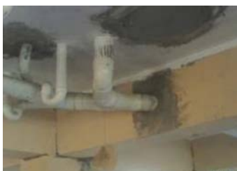
Perforación de elementos estructurales para paso de instalaciones
