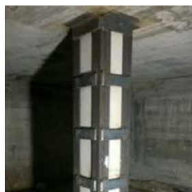
Reforzamiento de columnas
