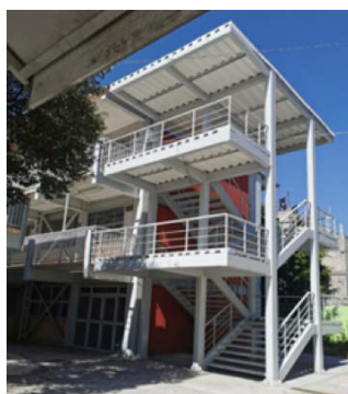
Escalera de emergencia
