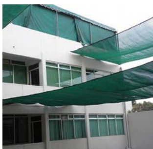
Colocación de malla sombra sobre elementos estructurales
