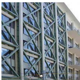
Colocación de contraventeos
