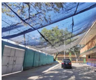
Colocación de malla sombra sobre elementos estructurales
