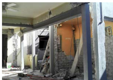
Reforzamiento de trabes
