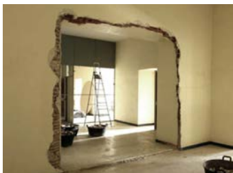
Demolición de muros de carga
