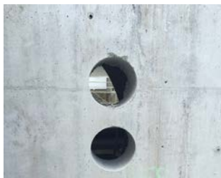
Perforación de muros de carga
