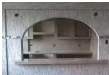
Apertura de vanos (huecos) en los muros de carga
