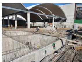
Cajón de cimentación
