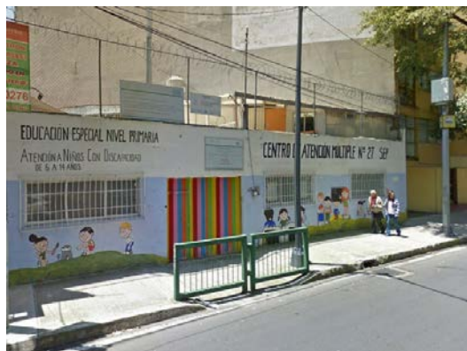
Puerta de acceso principal
