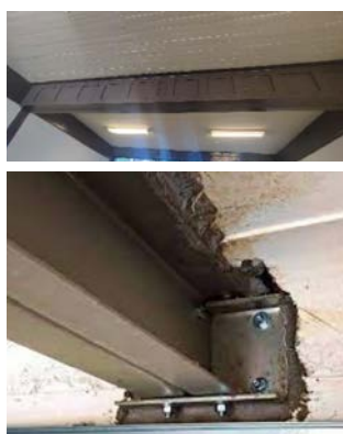
Reforzamiento de trabes
