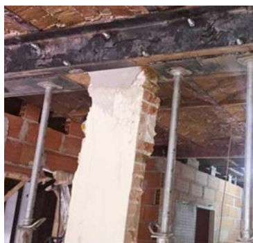
Retiro de perfiles de acero
