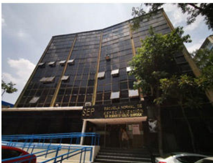
Escuela Normal de Especialización Superficie construida: 3,310 m 2
