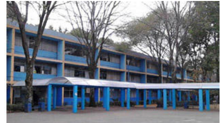
Escuela Superior Normal de México Superficie construida: 12,228 m 2
