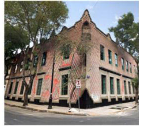
Muros de carga de mampostería
