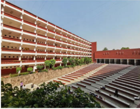
Benemérita Escuela Nacional de Maestros Superficie construida: 45,389 m 2
