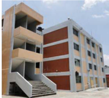
Marco rígido de concreto
